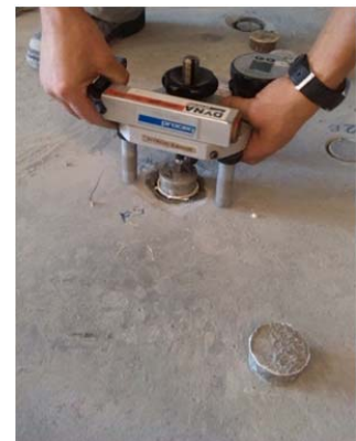
Figuur 1. Hechting test van SQAPE gietvloer gestort op cementbeton vloer
